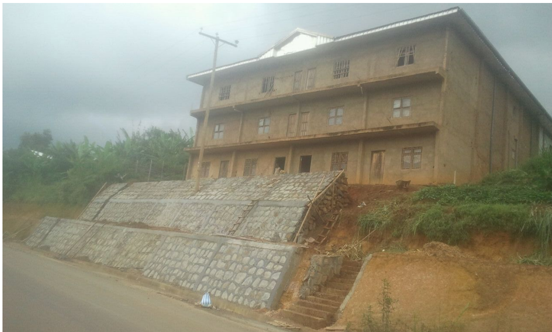
Bild 3: Fertig errichtete Stützmauer (seitlich) für das Rehabilitationszentrums-Gebäude der BERIKIDS in Babessi bei Kumbo in 2015
