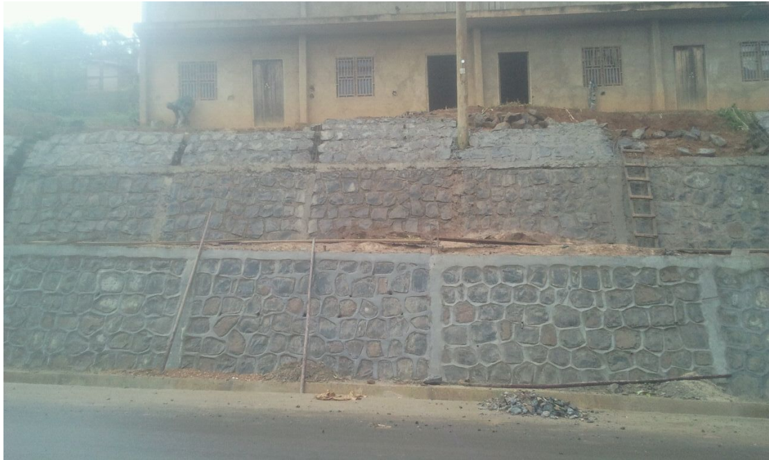
Bild 4: Fertig errichtete Stützmauer (von vorne) für das Rehabilitationszentrums-Gebäude der BERIKIDS in Babessi bei Kumbo in 2015
