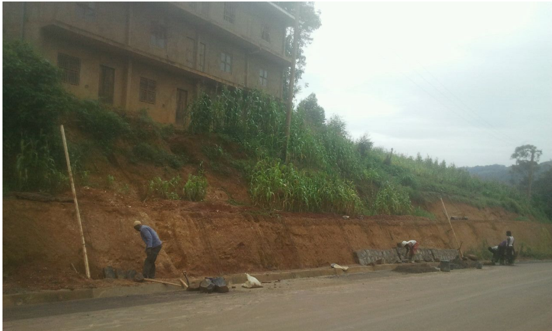
Bild 2: Errichtung der Stützmauer für das Rehabilitationszentrums-Gebäude in Babessi bei Kumbo in 2015
